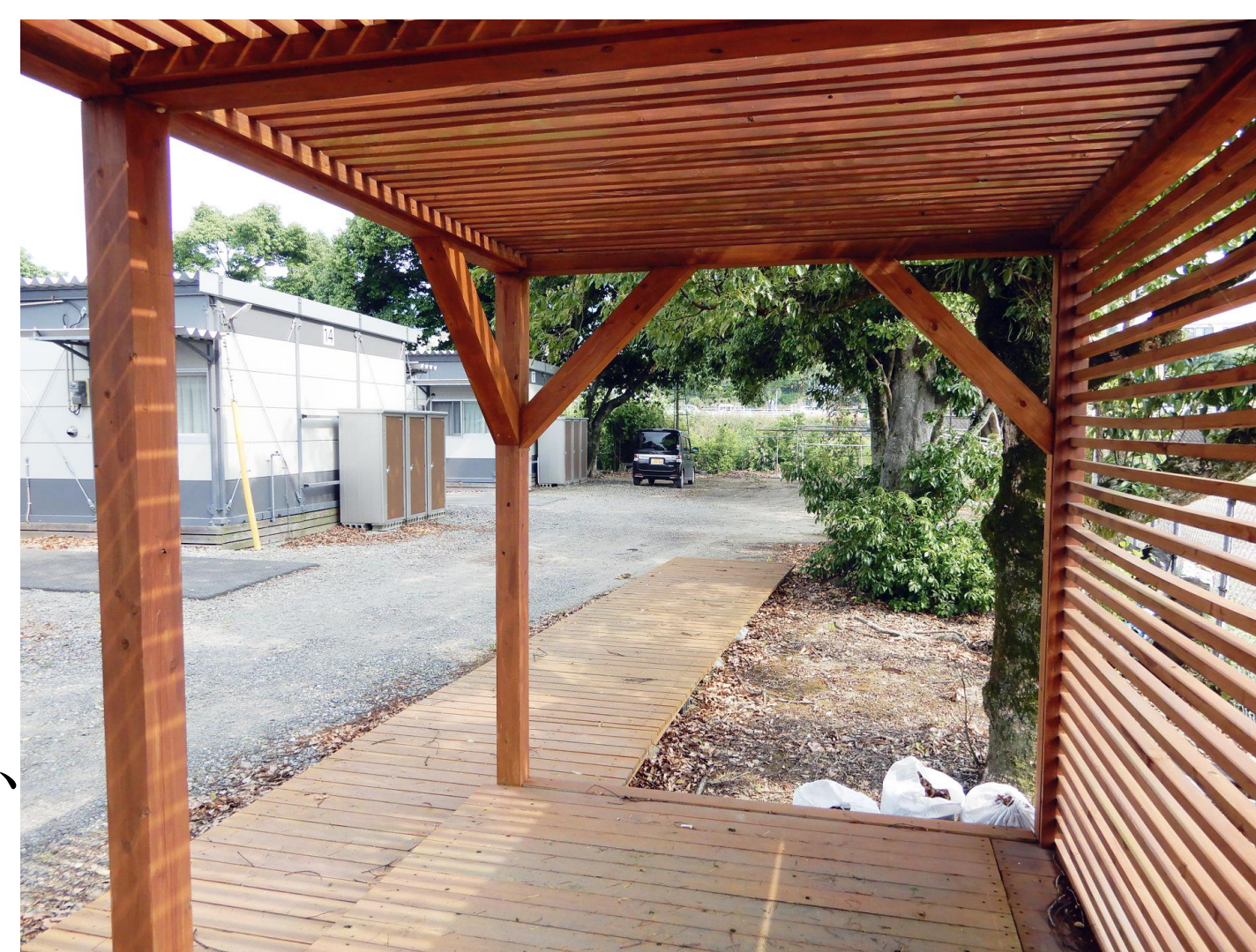
東屋内側から北側テラス、仮設住宅を望む
